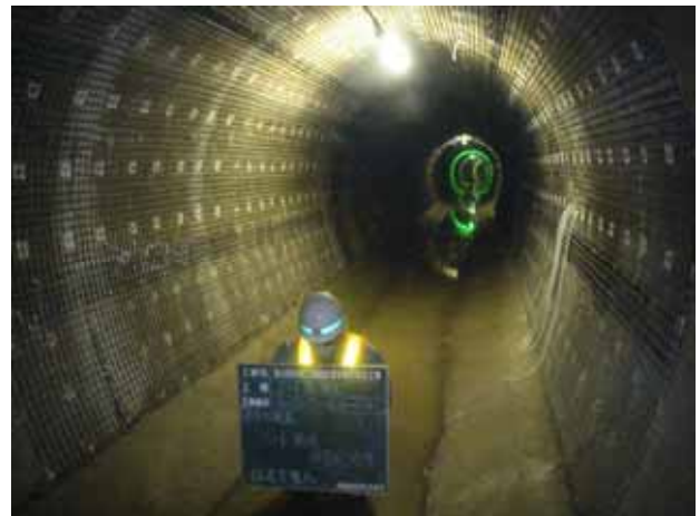
写真－6 カーボングリッド設置状況
