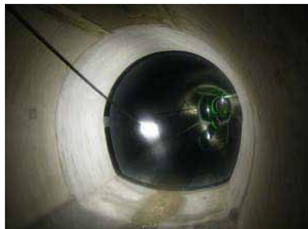
写真－8 鋼板設置完了写真
