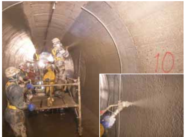
写真-4 PCM吹付け状況
