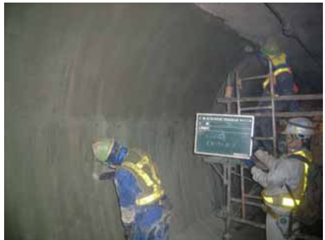
写真-5 PCMコテ塗り状況
