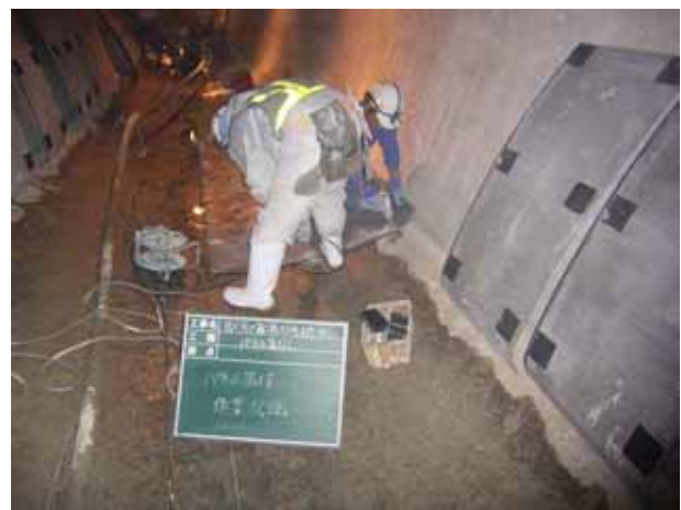
写真－7 ダクトパネル設置状況
