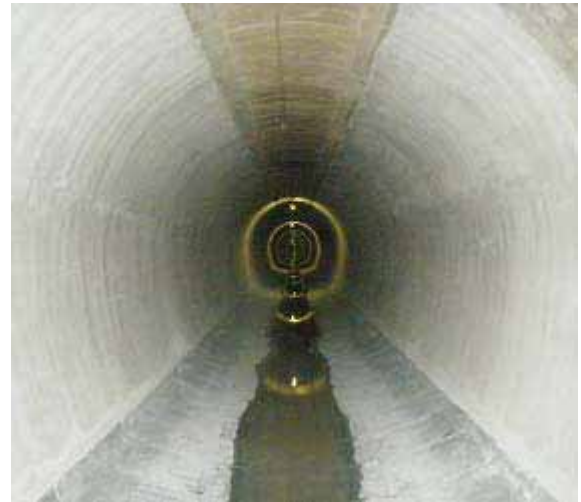
写真-1 標準部完成状況
