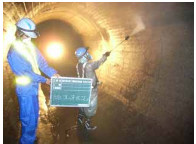
写真-2 洗浄工施工状況
