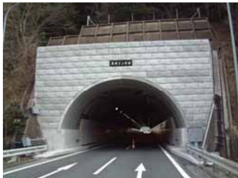
写真-2 トンネル坑口安定対策（完成）
