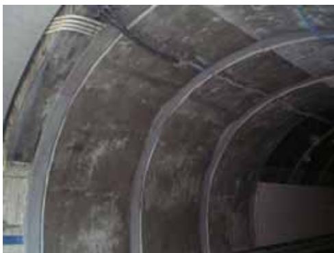
写真-3 覆工コンクリート補強（完成）
