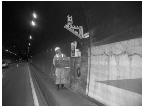
写真-3 Ⅰ期線計測機器設置状況
