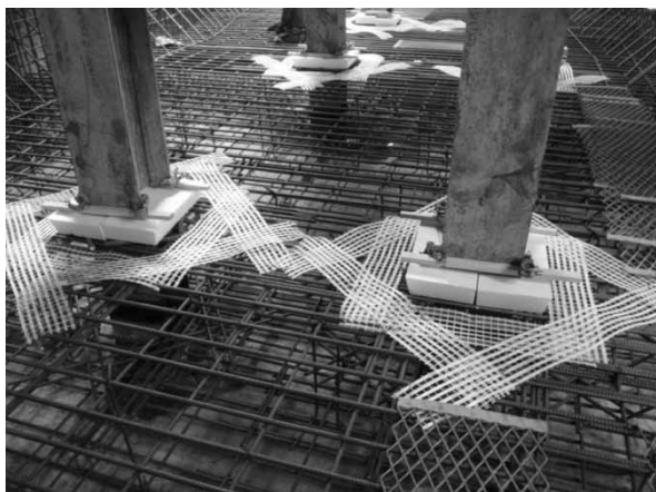
写真-1 ガラス繊維ネット設置状況
