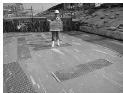
写真-2 ビニールシートによる湿潤養生状況 （上：柱、下：頂版）
