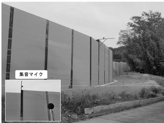
写真-4 防音壁・集音マイク設置状況
