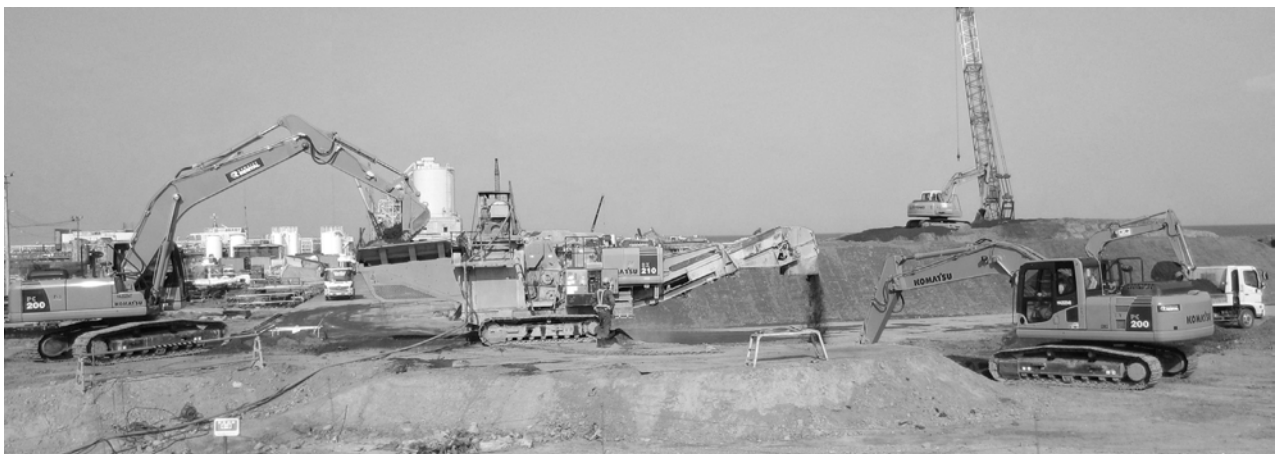
写真-1 混合状況
