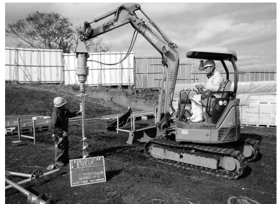
図-4 鋼管パイプ杭基礎打設状況
