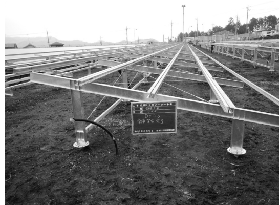
図-5 モジュール架台組立完了
