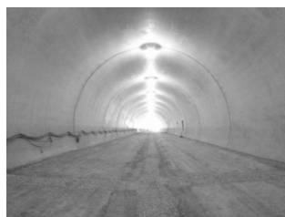
写真-2 覆工仕上がり状況
