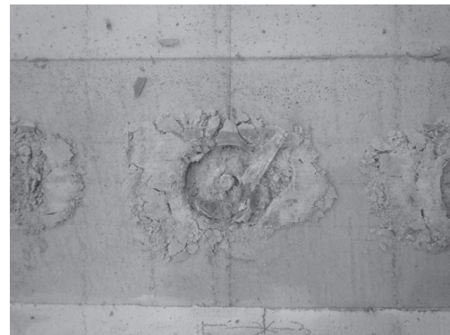
写真-1 直付け接合部実験の破壊状況の一例
