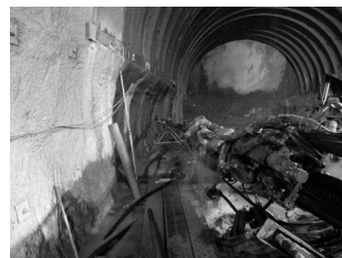
写真-1 ボーリング状況
