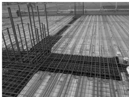
写真-6 溶接金網敷込完了
