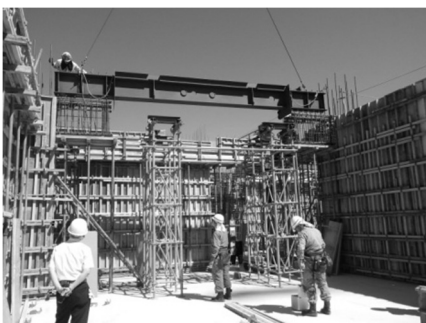
写真-3 鉄骨大梁据付状況 (複合梁部分)
