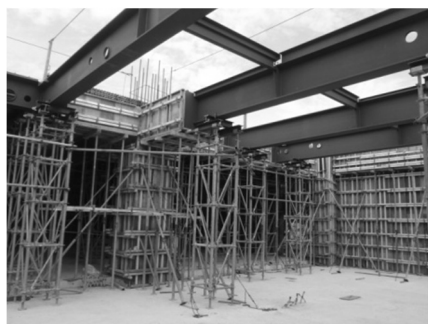
写真-4 鉄骨梁据付完了
