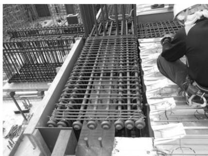
写真-5 複合梁上筋配筋完了
