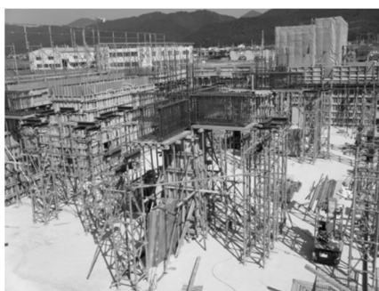
写真-1 鉄骨受け支保工組完了
