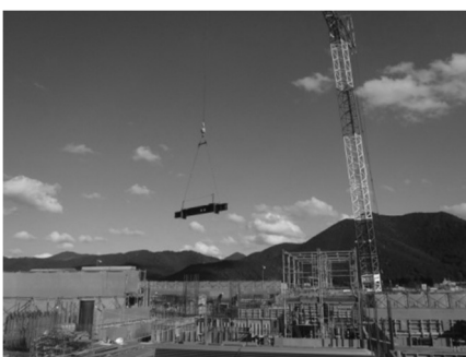
写真-2 鉄骨揚重状況 (190t クレーン)
