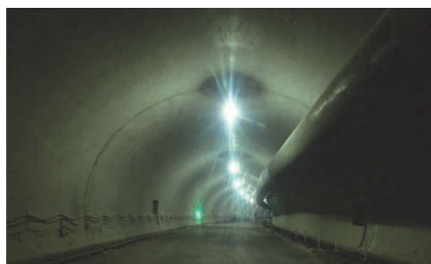
写真-6 覆工コンクリートの仕上がり状況
