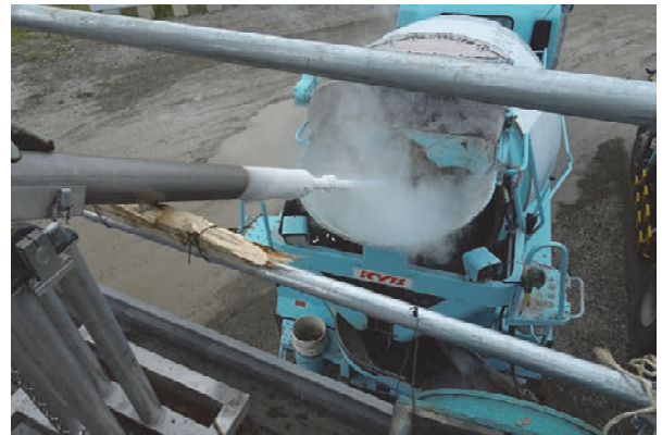
写真-1 液体窒素投入状況
