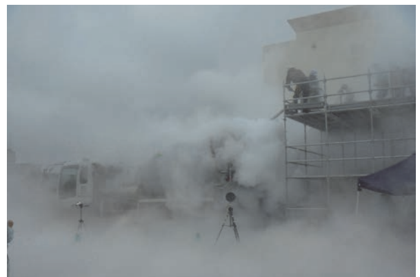
写真-2 クーリング実施時の白煙発生状況
