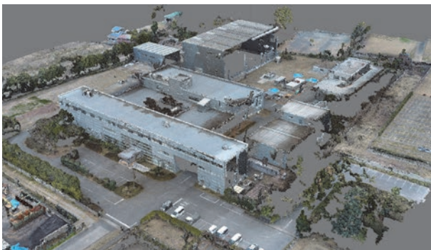
図-3 3次元写真測量による点群データ
