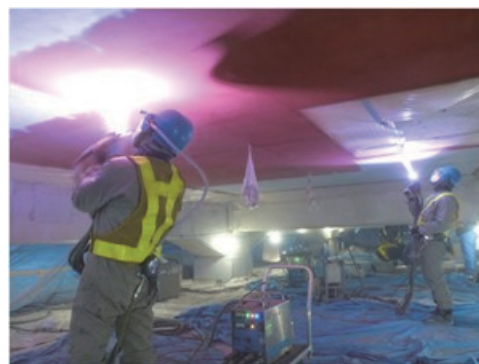
写真-1 流電陽極方式の施工状況
