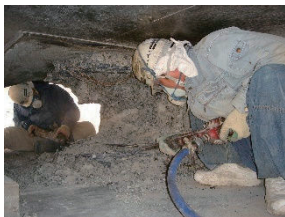
写真-7 人力破碎例
