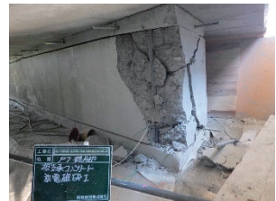
写真-10 放電破碎直後
