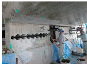
写真-8 コア抜き例
