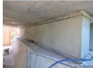
写真-9 ワイヤソー による切断完了
