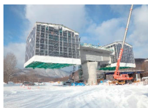
写真-1 超大型仮囲い
