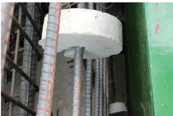
写真-10 柱側スペーサー
