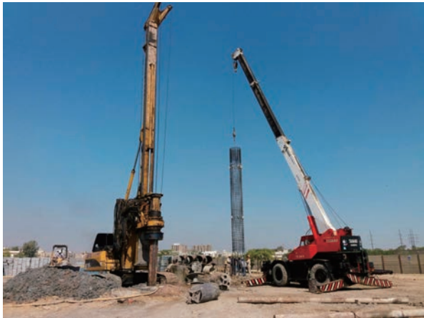
写真-3 杭施工状況
