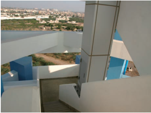
写真-17 ケーブルダクト完成
