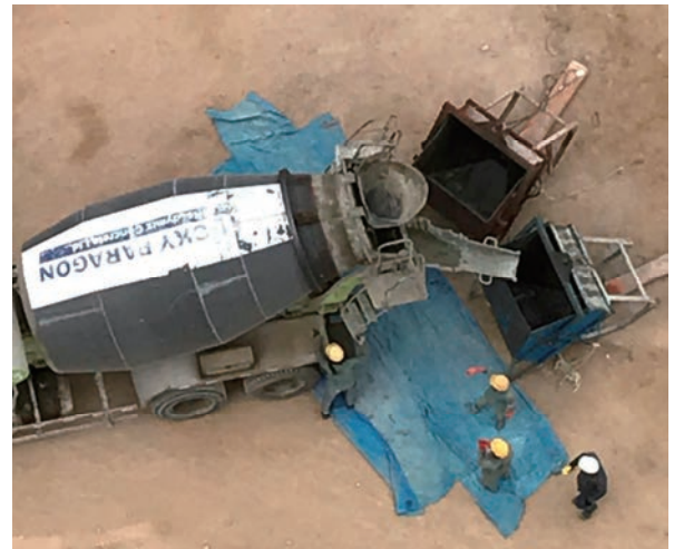
写真-16 コンクリート打設状況
