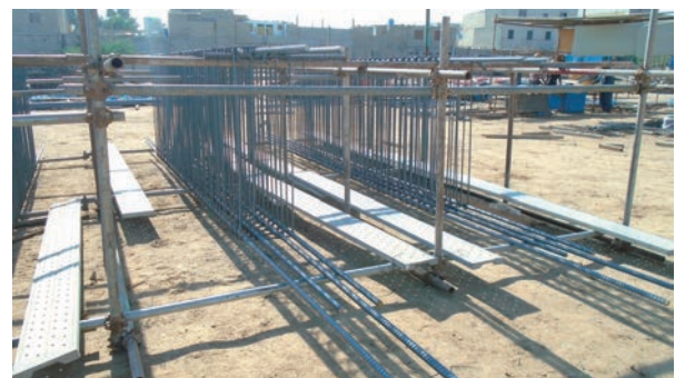
写真-12 梁鉄筋 地組状況
