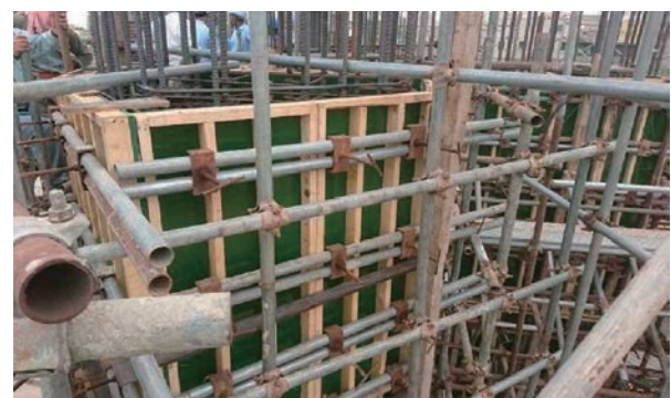
写真-14 型枠状況
