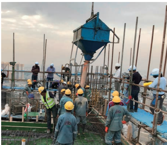
写真-15 コンクリート打設状況
