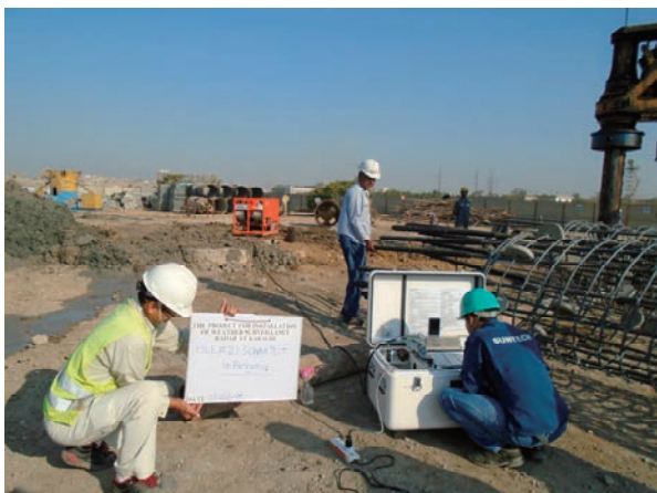
写真-4 孔壁測定状況
