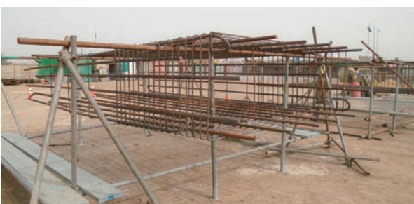
写真-11 柱鉄筋 地組状況
