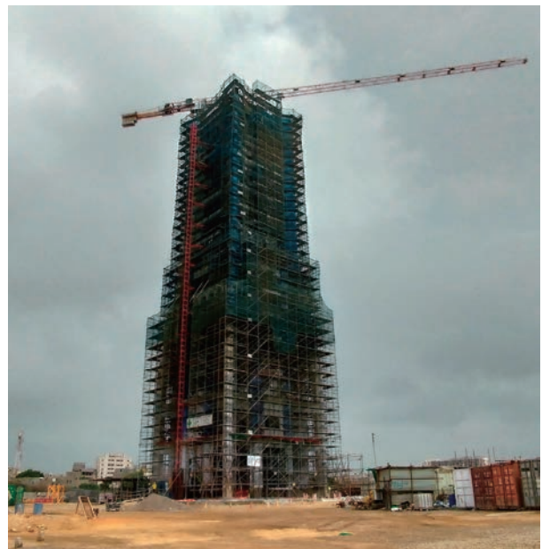
写真-2 足場架設状況
