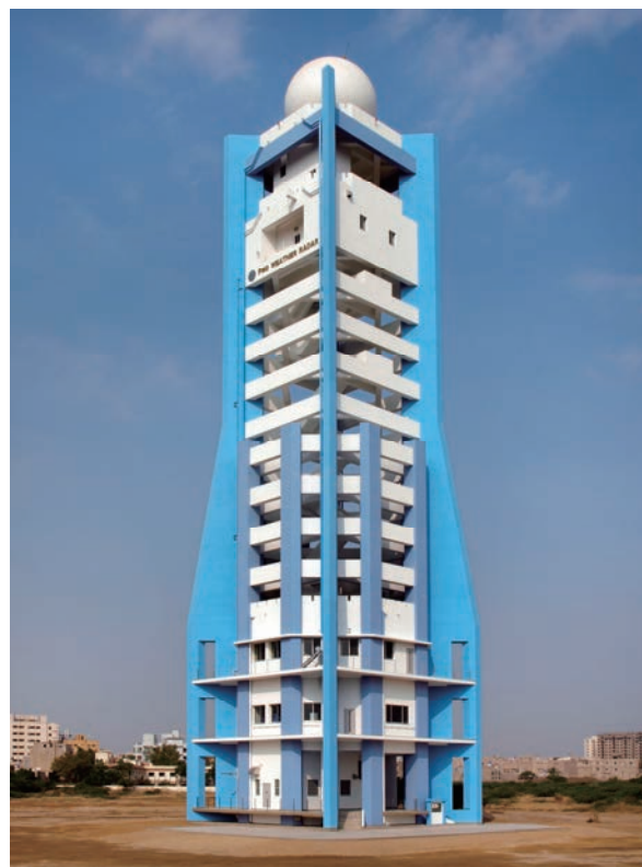
写真-1 完成写真
