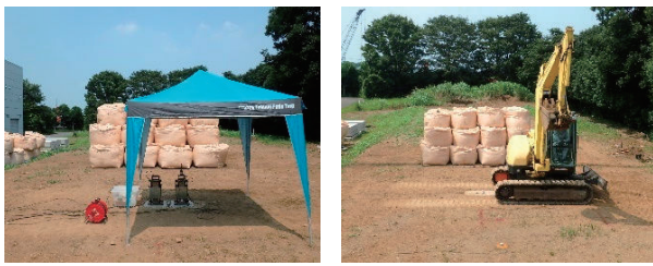
a) 起振器加振 b) 重機低速走行, 高速走行
