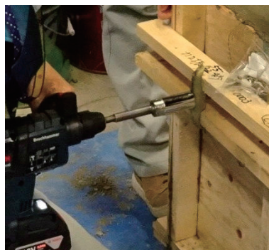
図-2 電動ハンマによる再振動実施
