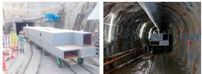
写真一 消音装置設置状況
