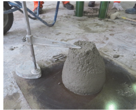
写真-2 要素実験用コンクリート (練上がり)
