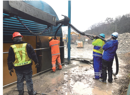
写真-3 要素実験実施状況
