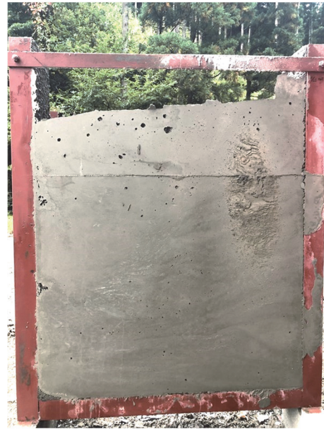
写真-8 脱型後のコンクリート
