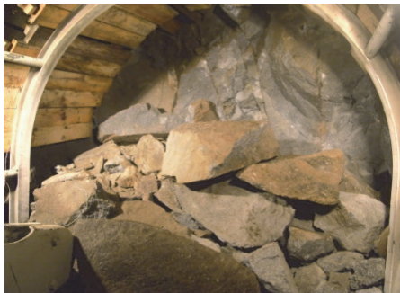
写真-12 岩塊の抜け落ち
