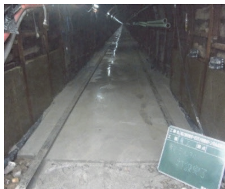
写真-15 充填モルタル敷設
