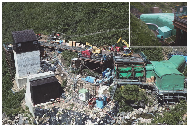
写真-6 仮設備ヤード全景
