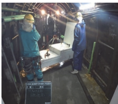
写真-17 坑内での回転状況
