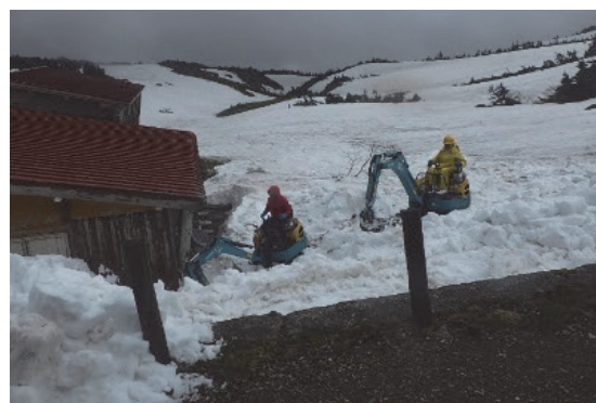
写真－8 南竜事務所除雪状況
