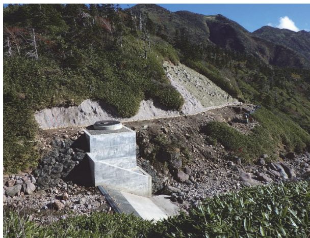
写真-20 呑口の状況(2021年10月)
