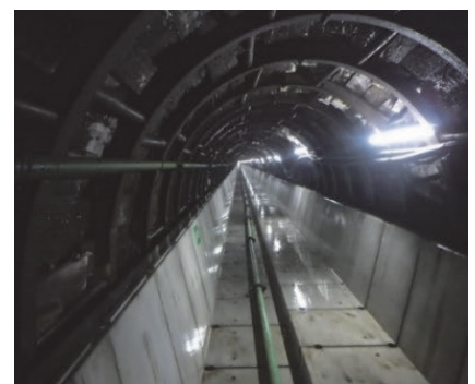
写真-19 施工完了
