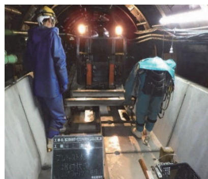
写真-18 据付け状況
