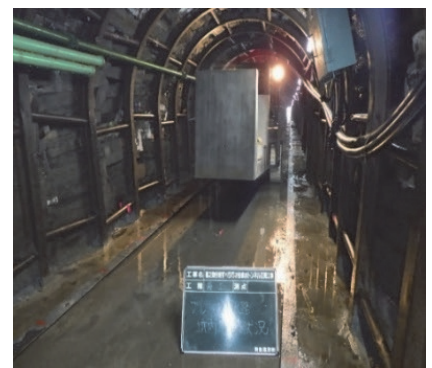
写真-16 坑内運搬状況
