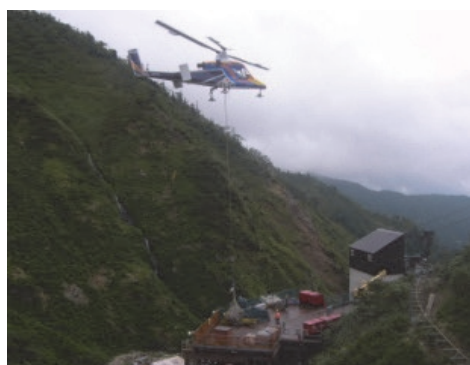
写真－7 ヘリコプターによる運搬状況
