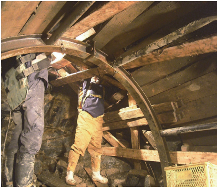
写真-11 当たり付け状況
