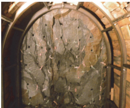
写真-13 削孔完了後
