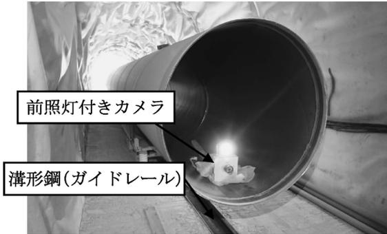
写真—4 内挿管運搬状況(前方側)
