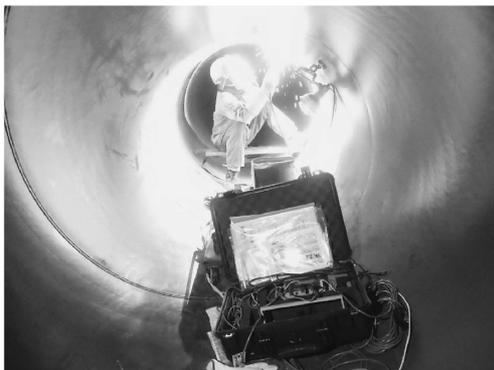
写真—5 溶接管理モニタを用いた溶接状況
