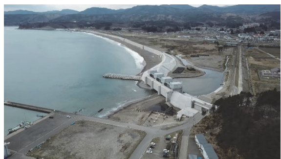
写真-4 竣工写真
