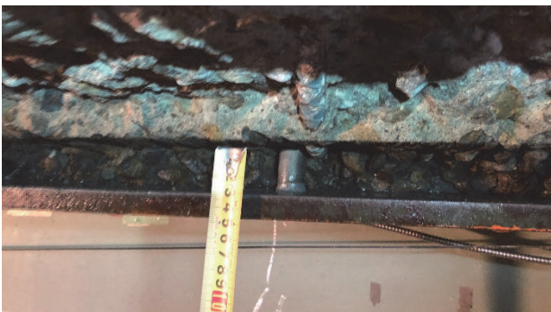
写真-3 ウォータジェットによる切削高さ
