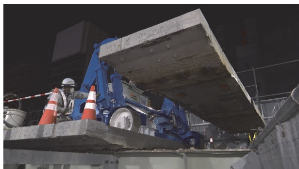
写真-9 現地における床版撤去作業状況
