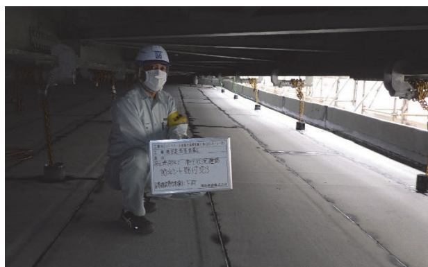
写真-1 防水型吊り足場（チェーン間隔5m）
