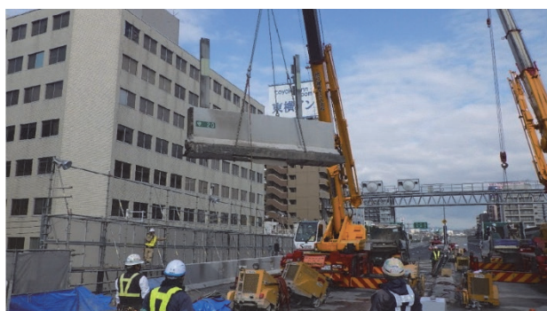
写真-7 高欄撤去状況
