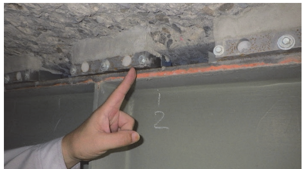
写真-4 補強材設置状況
