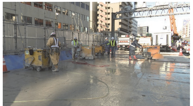
写真-6 床版切断状況
