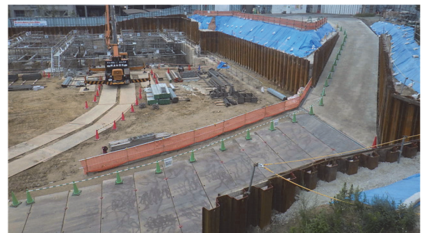
写真－2 仮設スロープ
