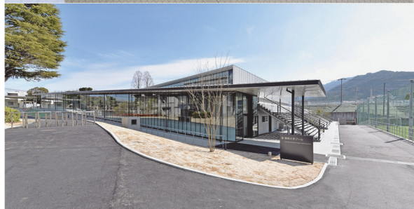
写真-4 竣工写真
