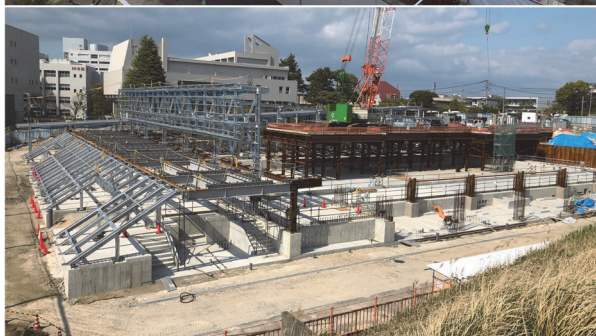
写真-3 作業構台
