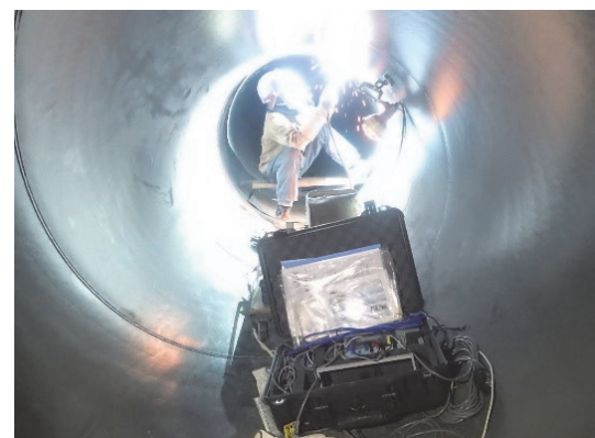
写真-4 溶接管理モニタを用いた溶接状況
