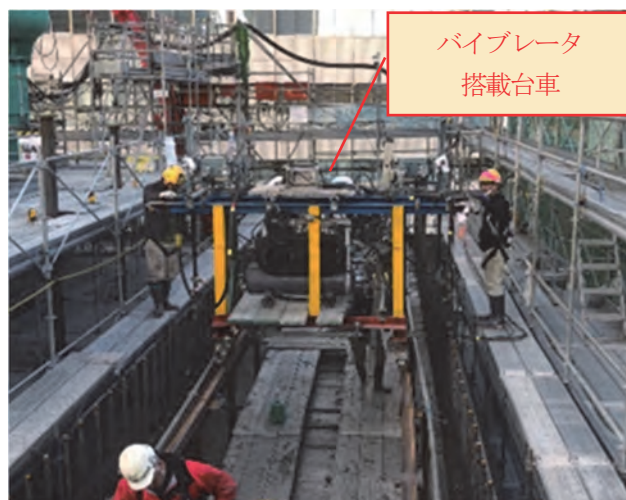
図-2 パイブレータ搭載台車による締固め状況
