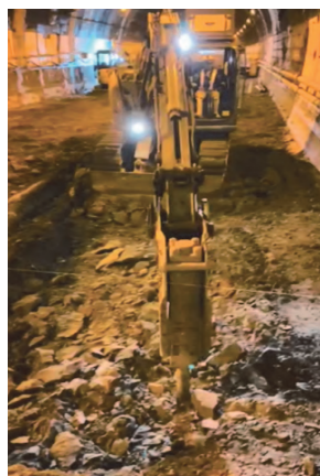
ブレイカによる岩砕【初期掘削】
