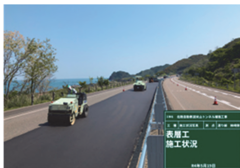
写真-1 渡り線施工状況
