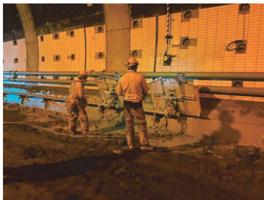
写真－4 覆工脚部の切断状況
