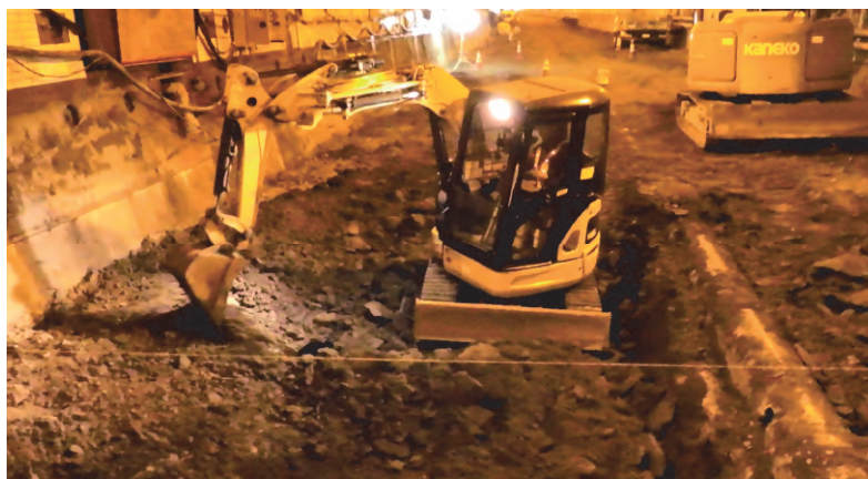
小型バックホウ掘削【初期掘削】
