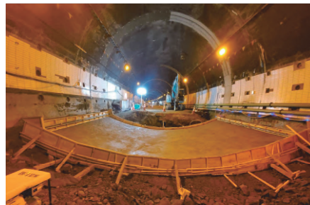
コンクリート打設完了
