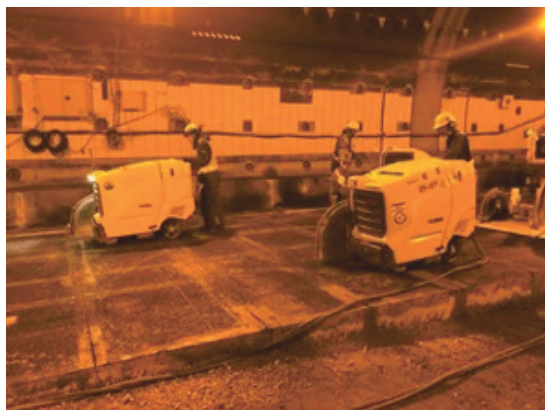
写真－3 コンクリート舗装版撤去状況
