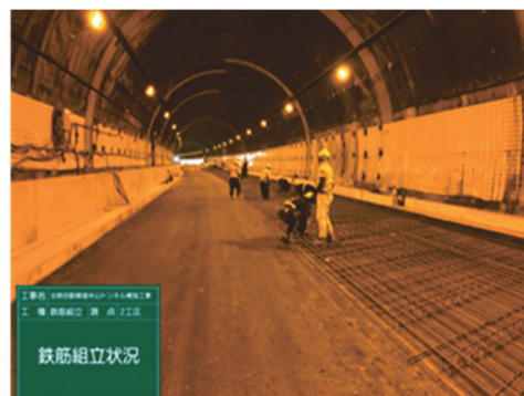
写真ー７ 鉄筋工施工状況
