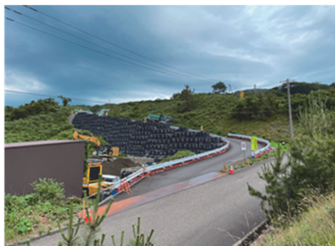
写真-2 工事用道路全景
