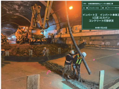
コンクリート打設状況
