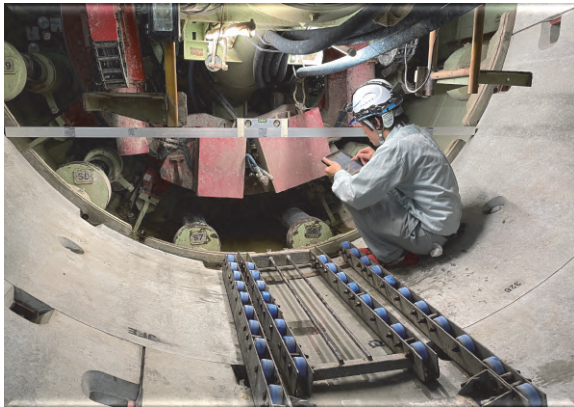
写真-6 ワンマン測量実施状況
