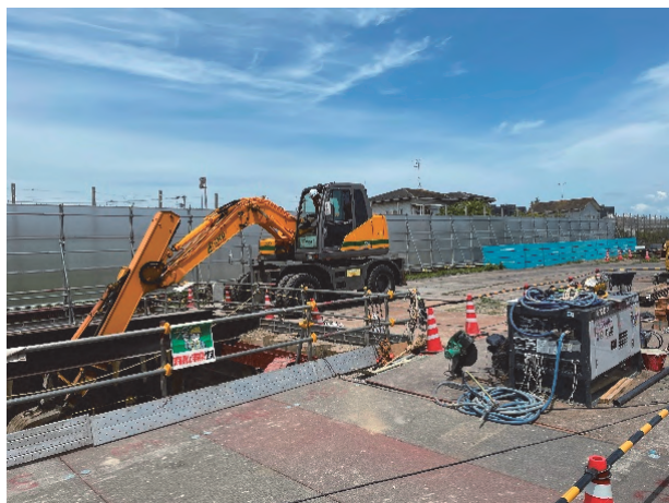
図－2 質量体の現場適用状況
