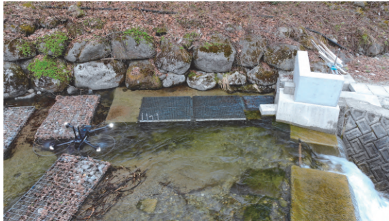
写真-2 UAVによる設備点検の状況
