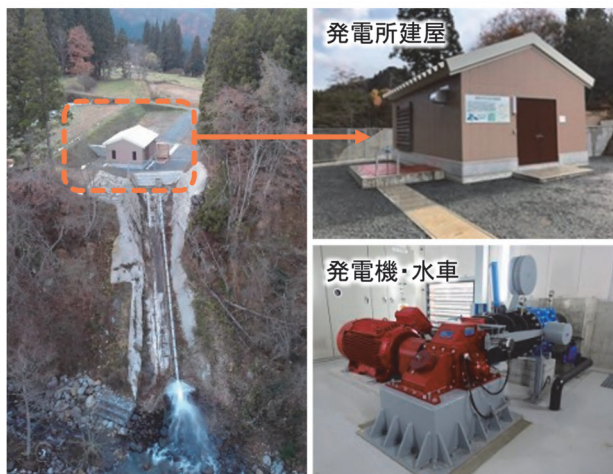
写真-1 米沢大平小水力発電所の設備概要
