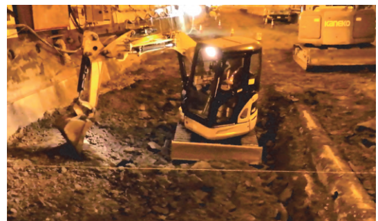
小型バックホウ掘削【初期掘削】
