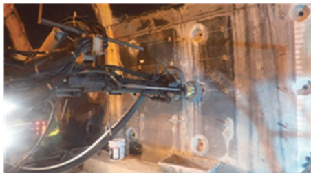
写真-1 補強ボルト施工状況
