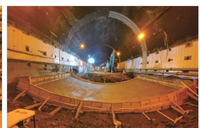
コンクリート打設完了 写真-3 インバート工施工状況
