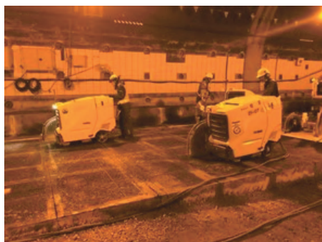
写真-2 舗装撤去状況
