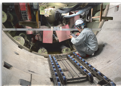
写真-1 ワンマン測量実施状況
