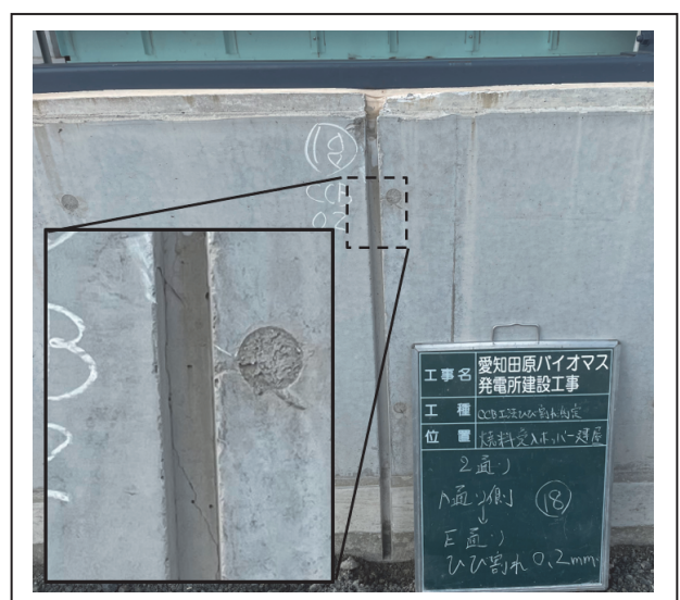
写真-1 CCB工法によるひび割れ誘発状況
