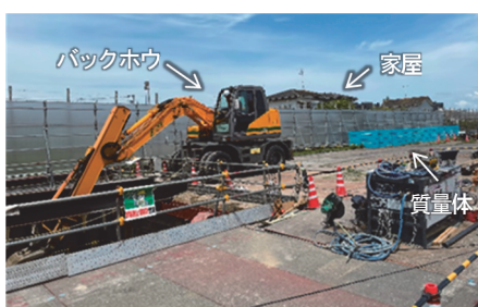
図－1 質量体の現場適用状況
