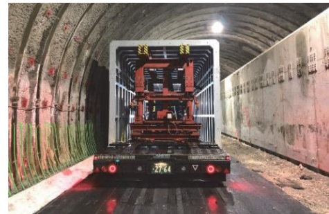
写真-3 プロテクター運搬・設置状況
