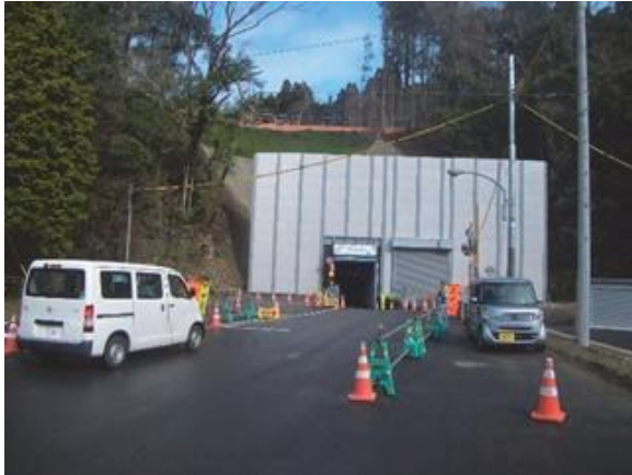
写真-5 終点側遮音壁
