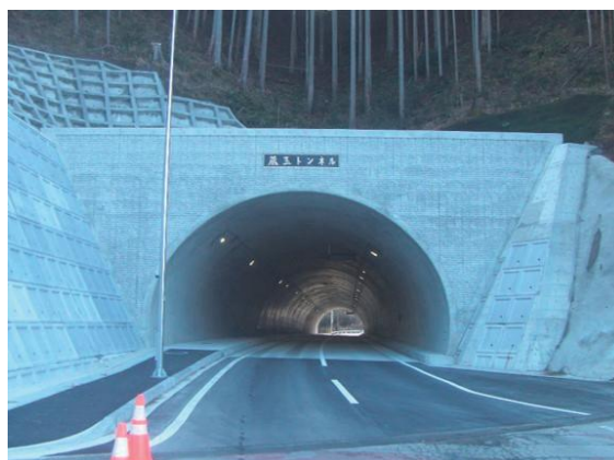
写真－10 工事完成状況（起点側）
