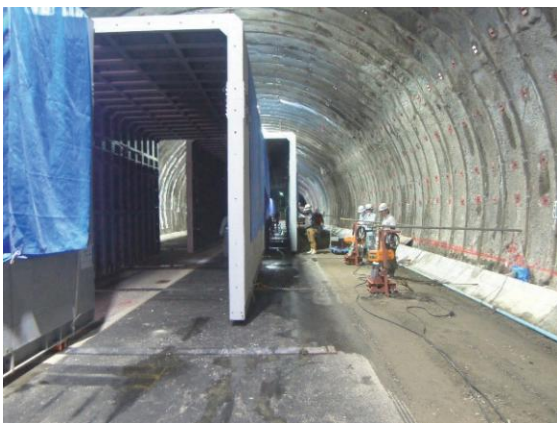
写真-4 プロテクター横移動状況
