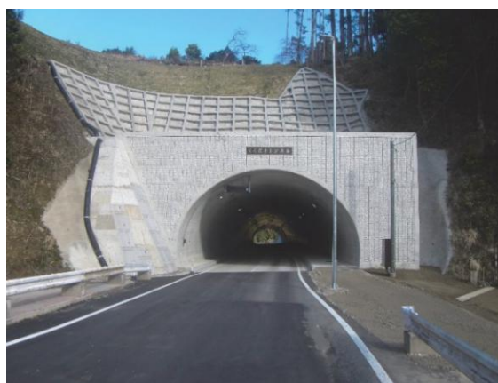
写真－11 工事完成状況（終点側）
