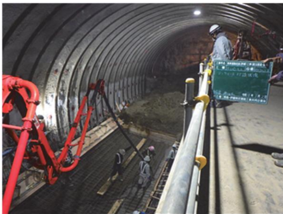
写真-6 終点側インバート施工
