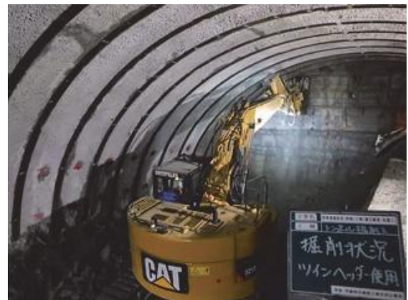
写真-9 掘削状況 (坑道換気)
