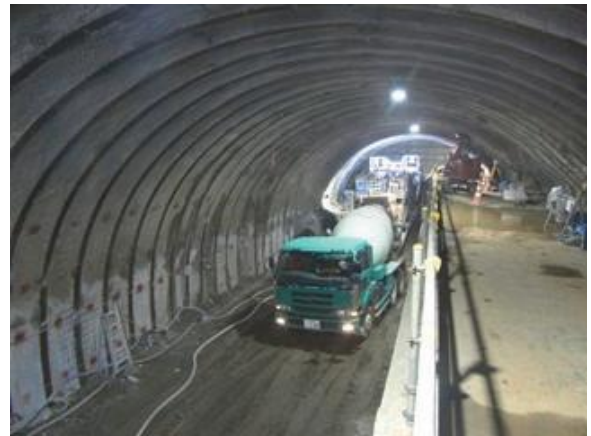
写真-8 吹付け状況 (坑道換気)
