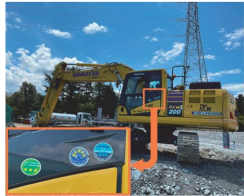
写真－４ 排出ガス対策型バックホウ
