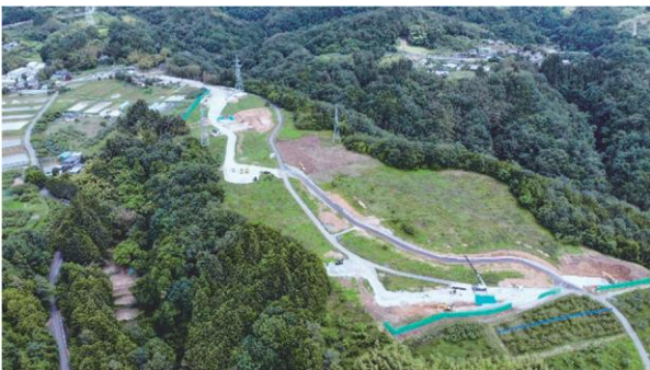
写真－３ 豊丘変電所敷地造成工事の状況
