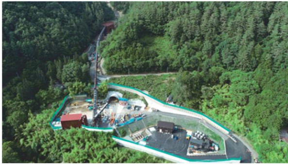
写真－１ 非常口トンネル（戸中）坑口および仮設ヤード
