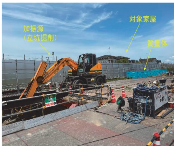
図ー３ 質量体の現場適用状況 3)
