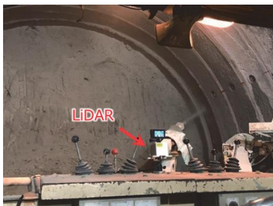
図－4 現場実験による適用性検証の状況
