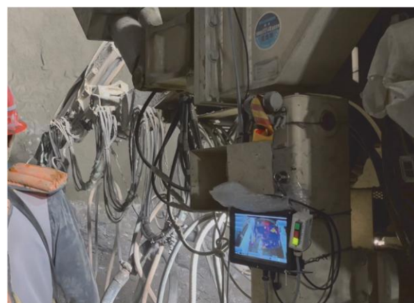
図-11 吹付けオペレータによるモニタ確認
