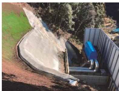
写真-5 集じん機・遮音壁設置 (H=12m)
