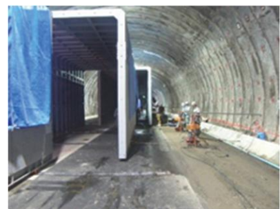
写真-3 プロテクターB中央移動状況
