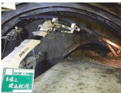
写真-1 支保工建込状況
