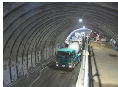
写真-6 吹付状況 (坑道換気)
