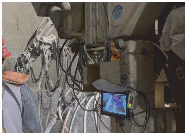
図ー2 吹付けオペレータによるモニタ確認
