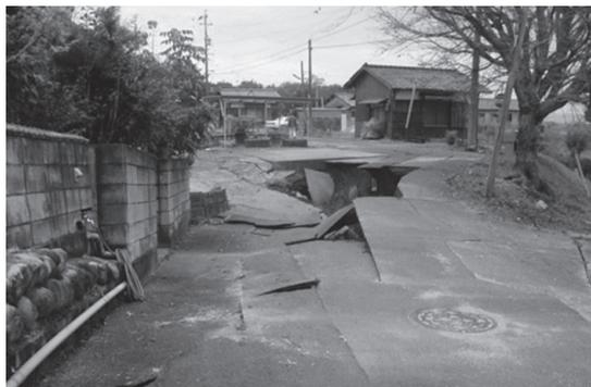
写真1 亜炭廃坑に起因した陥没状況
