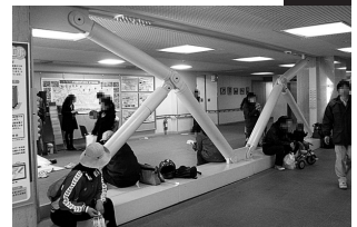
東日本大震災後の仙台市役所の制震装置。震度6強を観測した仙台では多くの建物が損傷したが、トグル制震ブレースにより損害をまぬかれた建物は、被災者の避難所として人々の安全を確保し注目を集めた。
