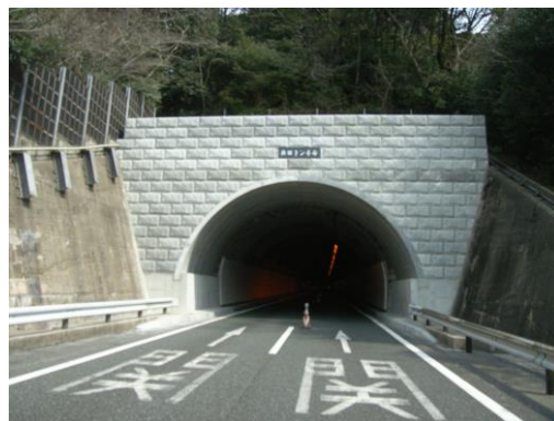
写真-4 奥田トンネル入口面壁補強完成
