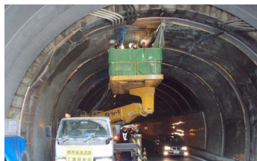
写真-7 モルタル吹付け状況
