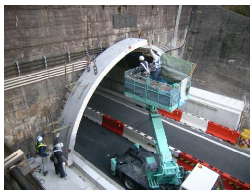
写真-2 プレキャストアーチ部材架設状況
