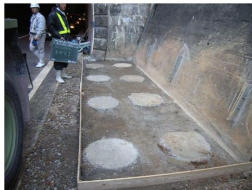
写真-1 コンクリート柱設置状況
