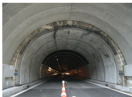
写真-8 覆工補強完成（奥田トンネル出口）
