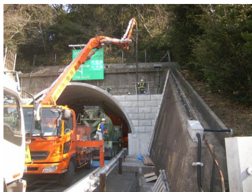
写真-3 増し打ちコンクリート打設状況
