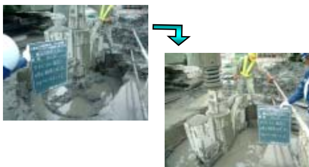
写真-4 ロータリーサポートの挿入
