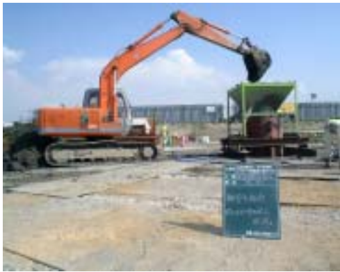
写真-12 鋼管矢板内先行埋め戻し
