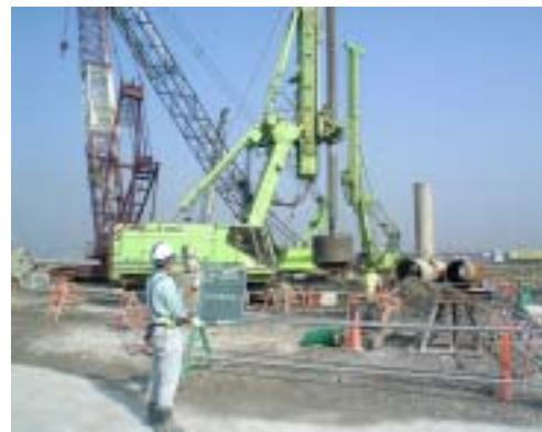
写真-7 アースドリル掘削
