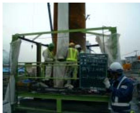
写真-5 土木シート接続
