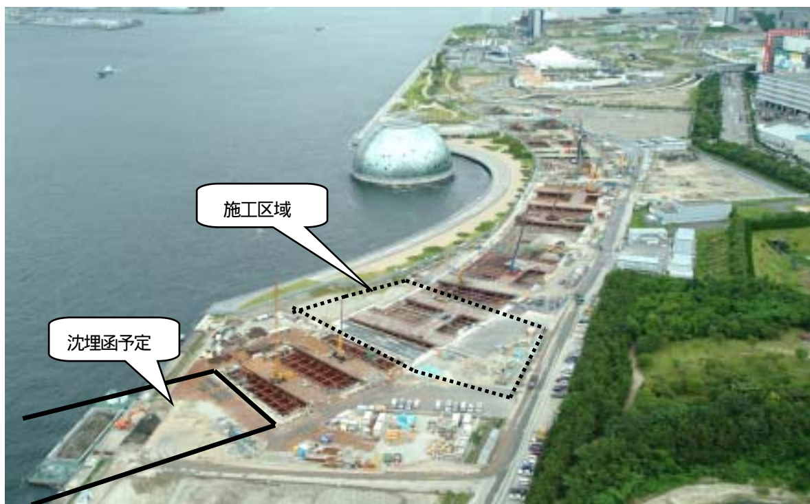
写真-2 夢洲トンネル咲洲側アプローチ全景
