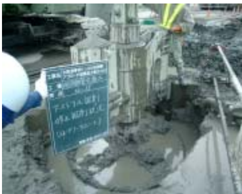
写真-9 修正掘削
