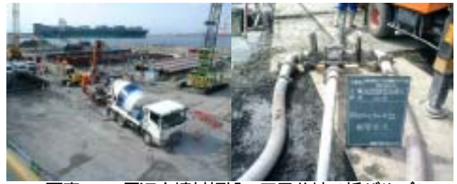
写真-13 周辺充填材打設, 三又分岐 (板バルブ)
