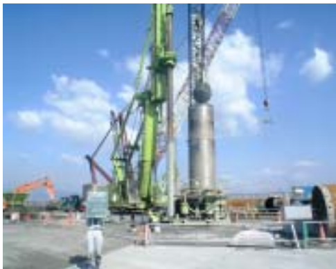
写真-6 全旋回オールケーシング掘削
