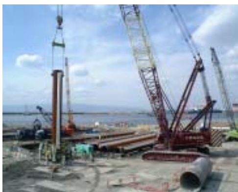
写真-10 鋼管矢板建て込み
