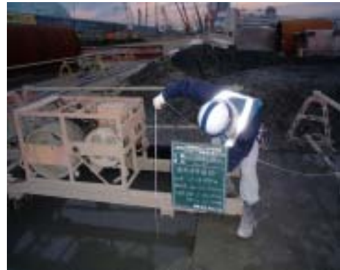
写真-8 孔壁測定、掘削深度確認
