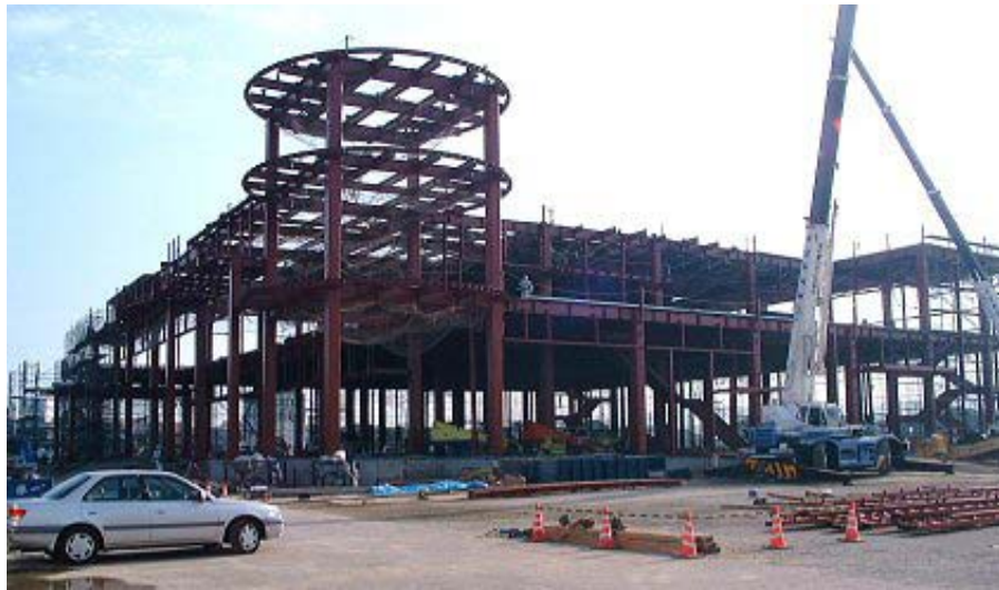
写真 - 6 : ワシントン春坂店鉄骨工事全景
