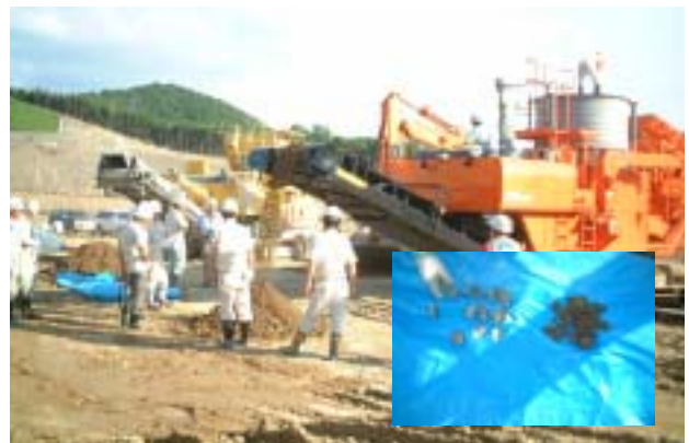
写真 - 6 現地発生土分級試験
