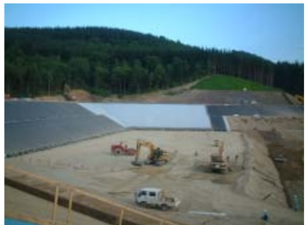
写真 - 7 粘土ライナー（ベントナイト混合土）施工状況
