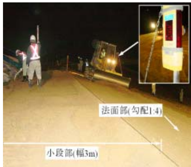
写真 - 10 レーザーレベル作業状況
