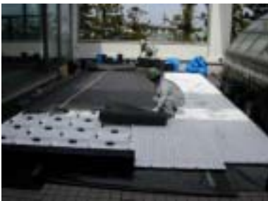
CAフィルター敷設
