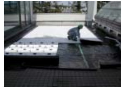
CAパネル敷設
