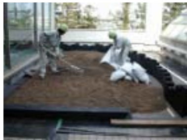
CAソイル投入・敷き均し
