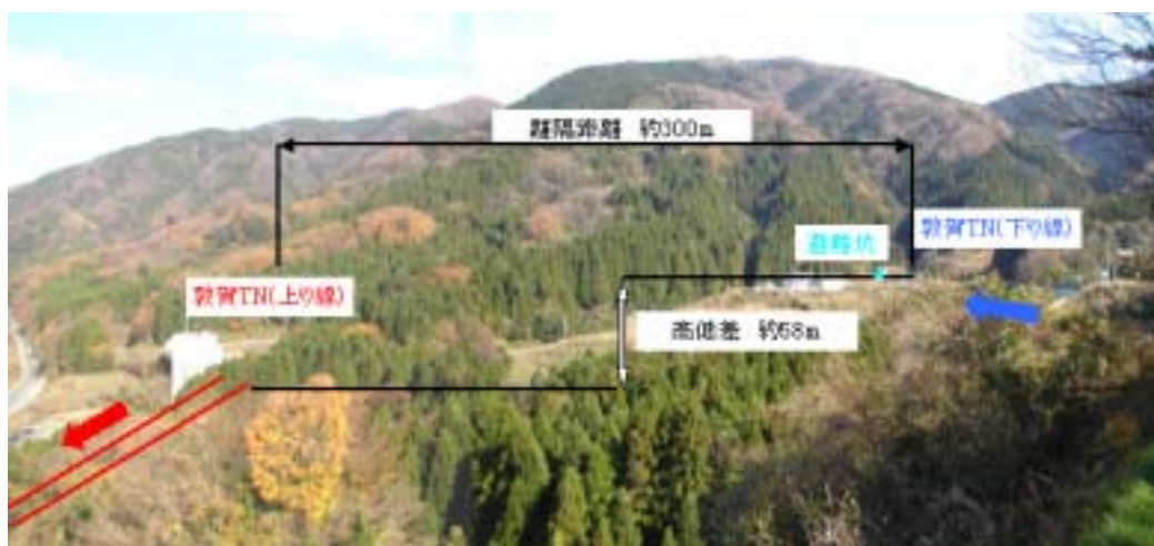
写真-1 敦賀トンネル坑口（敦賀方）
