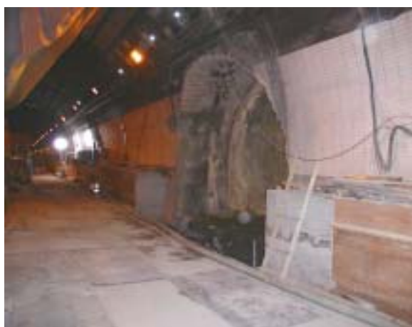
写真-6 車道部貫通
