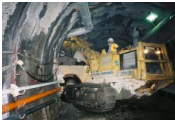
写真-3 人道ずり積み替え (CAT953:1.5m 3 →ORD:15t)
