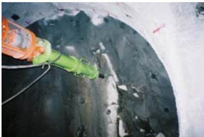
写真-4 ビッカーによる割岩
