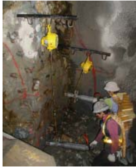
写真-5 二連装備によるダルダ割岩状況
