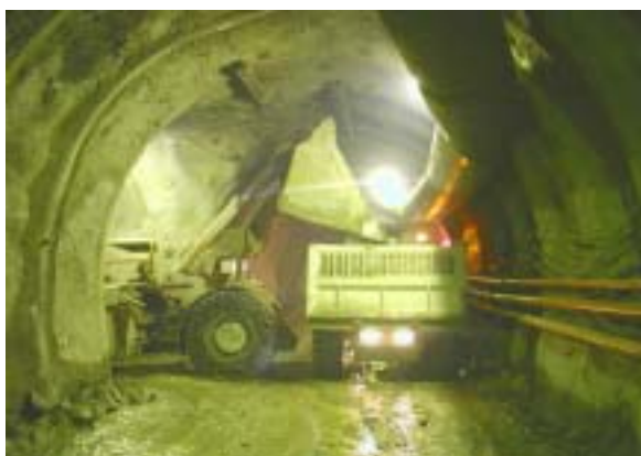
写真-2 車道ずり積み替え (RHD:3.0m 3 →ORD:15t)
